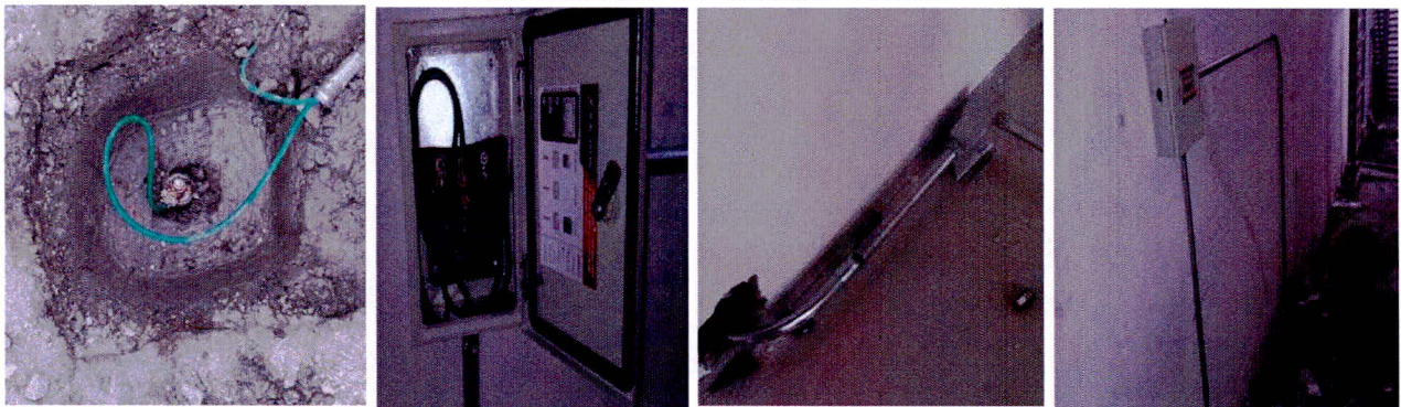
Instalación de tierra física.
