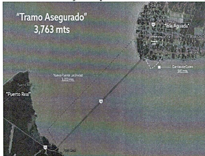
Figura 1 Tramo asegurado puente "La Unidad".
